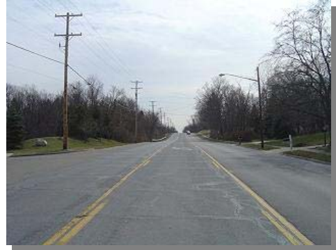
S. Dixie Dr. Before Construction
