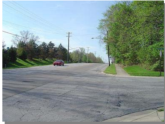
S. Dixie Dr. Before Construction
